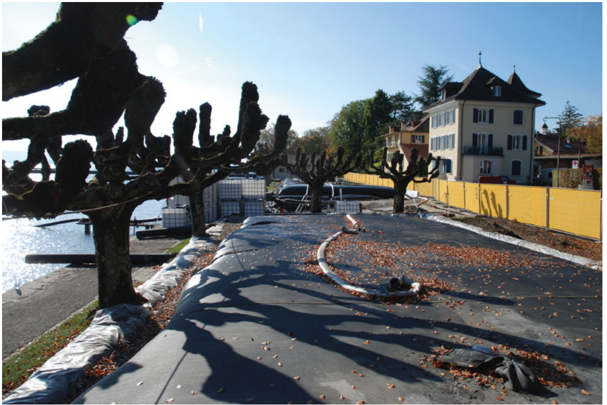
Mehrere vorbereitete Einfüllstutzen ermöglichen die optimale Befüllung der Schläuche.
