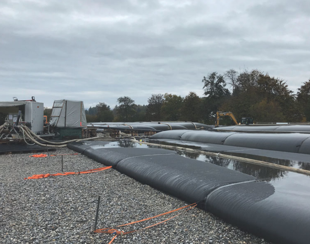
Die ersten «SoilTain»-Entwässerungsschläuche werden verfüllt.
