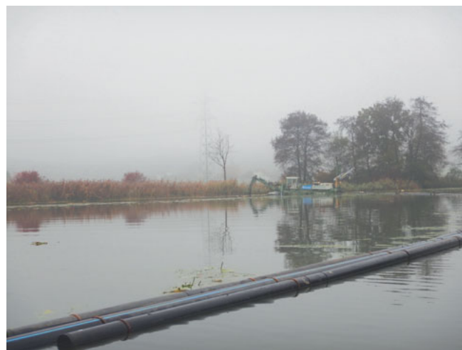
Saugbagger mit schwimmender Transportleitung.
