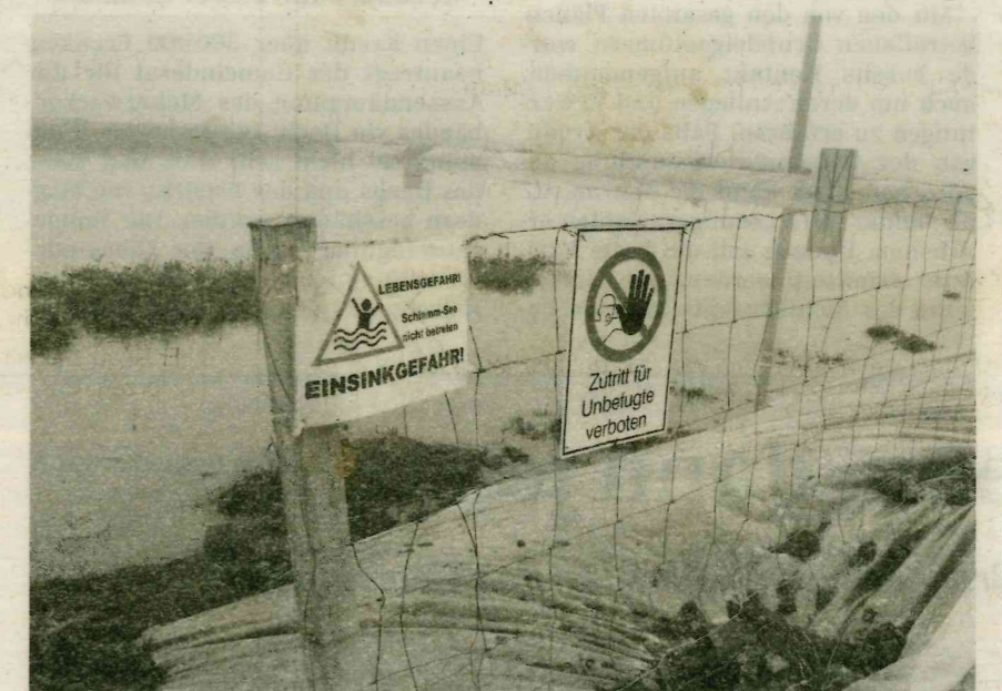
Im Sedimentsbecken trennen sich Wasser und Sand.
